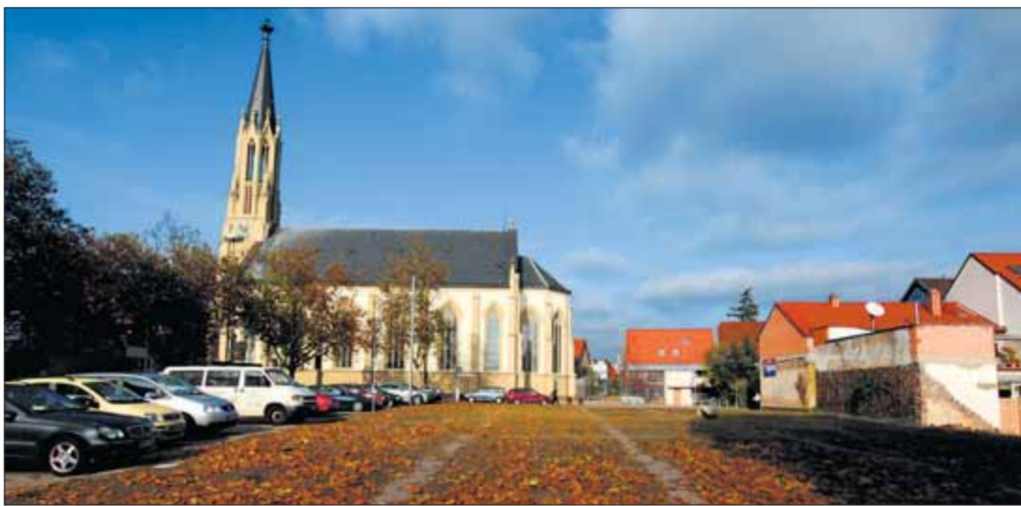
Der Gemeinderat hat jetzt grünes Licht für eine Bebauung des brach liegenden Drehscheiben-Geländes in kommunaler Trägerschaft gegeben. Dort sollen Einzelhandel und Fachärzte angesiedelt werden, außerdem wird ein ÖPNV-Knotenpunkt geschaffen. Foto: Pfeifer
